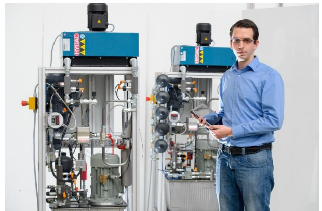
Sensorbasierte Elektroniksysteme können Maschinen und Anlagen lückenlos in Echtzeit überwachen. (Quelle: Oliver Dietze)
